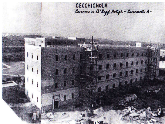
Lavori di Costruzione dell'attuale Palazzina Bevilacqua - Caserma "Ettore Rosso"
